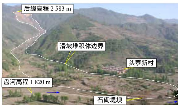
图8 头寨滑坡-土石流堆积<sup>[27, 28]</sup>
